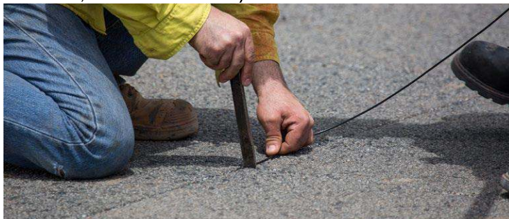
Instalación de los lazos inductivos.
